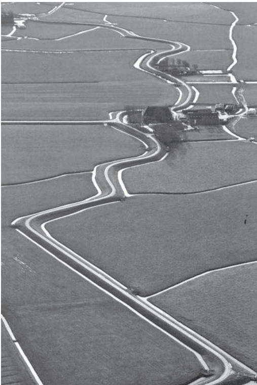
Slachtedijk near Oosterbierum, Fryslân, NL (Photo: H. Scharzbach)
